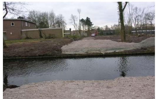
aanleg van de bouwweg
